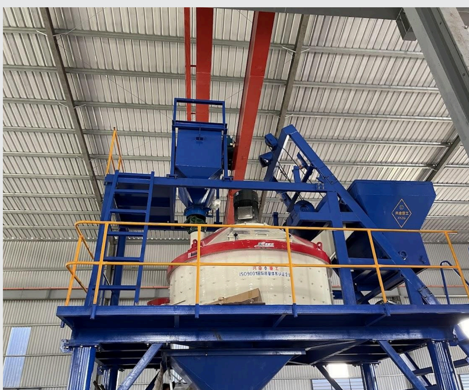
Máy trộn bê tông
